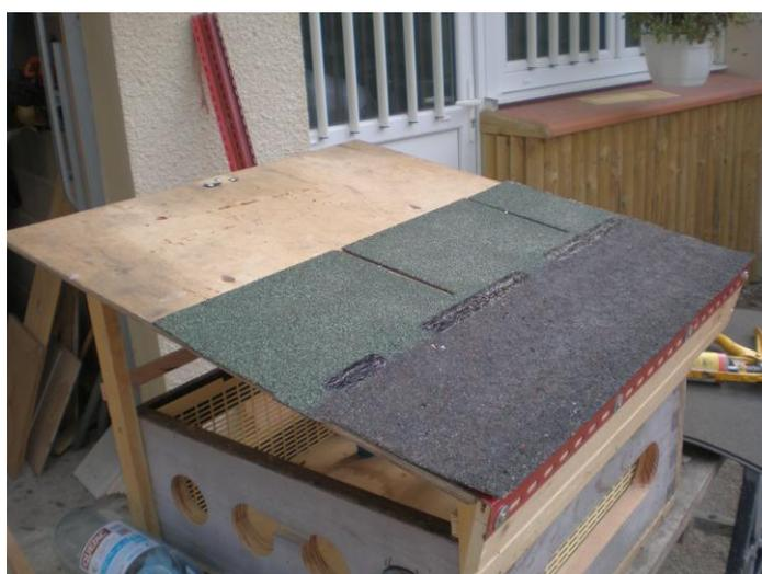
Mise en place « d'une jupe arrière » pour protéger le piège des pluies dominantes et collage de « papier goudronné » pour étancher la couverture...
